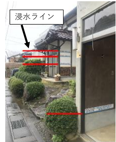
浸水の度に浸水地点を記録 されている。
